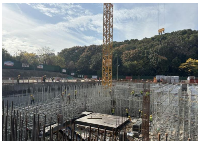
地下结构工程施工
