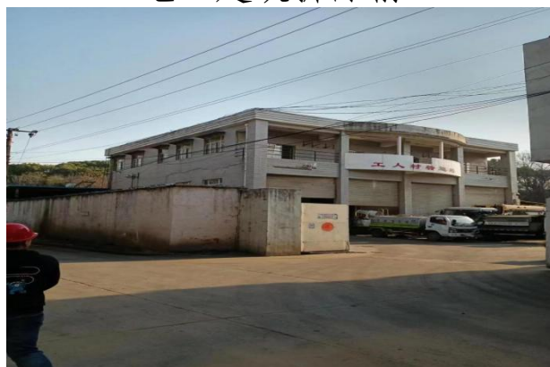
地上建筑拆除前
