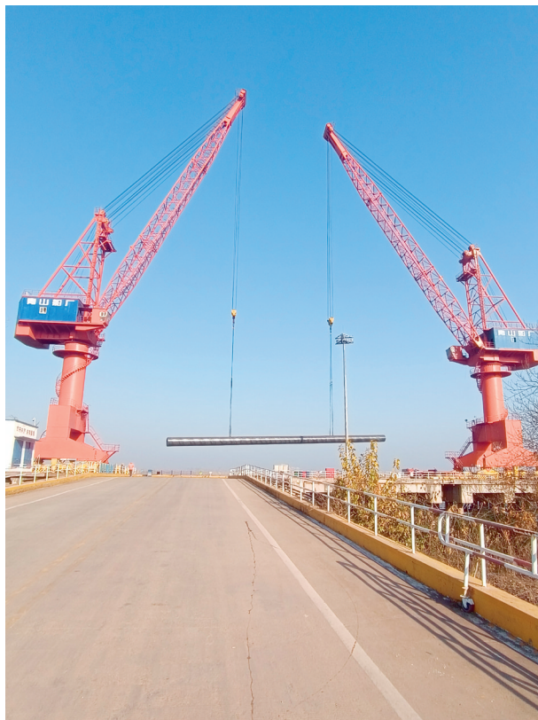
2022年12月24日,青山船厂物流事业部吊装钢管桩现场 (何书鹏摄)
