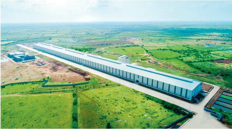
2022 年 4 月 15 日,中国一冶承建的印度克罗美尼(CHROMENI)不锈钢项目获得 2020—2021 年度中国建设工程鲁班奖(境外工程) (尹志远摄)
