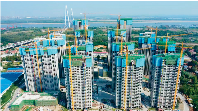
2022 年 9 月 16 日,武汉化工区新集还建房一期项目主体结构封顶 (王鹏 摄)
