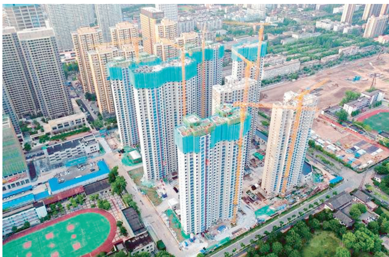
2022年7月20日,青山区三十五街坊还建房7栋高层住宅主体结构封顶 (区更新局供图)
