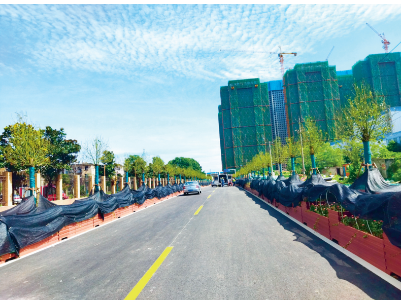
2022年7月15日,青山区船舶园小路项目完工
